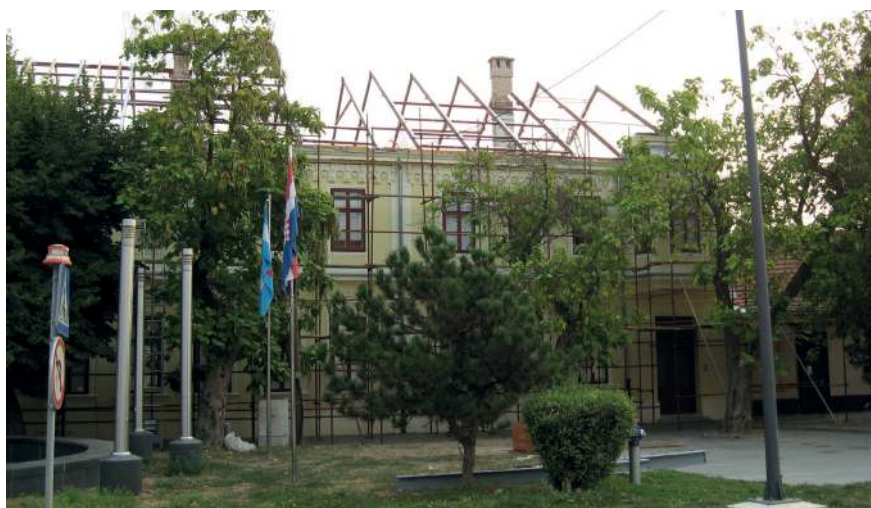
radovi na obnovi Palače Jirkovsky ▲ ▼
